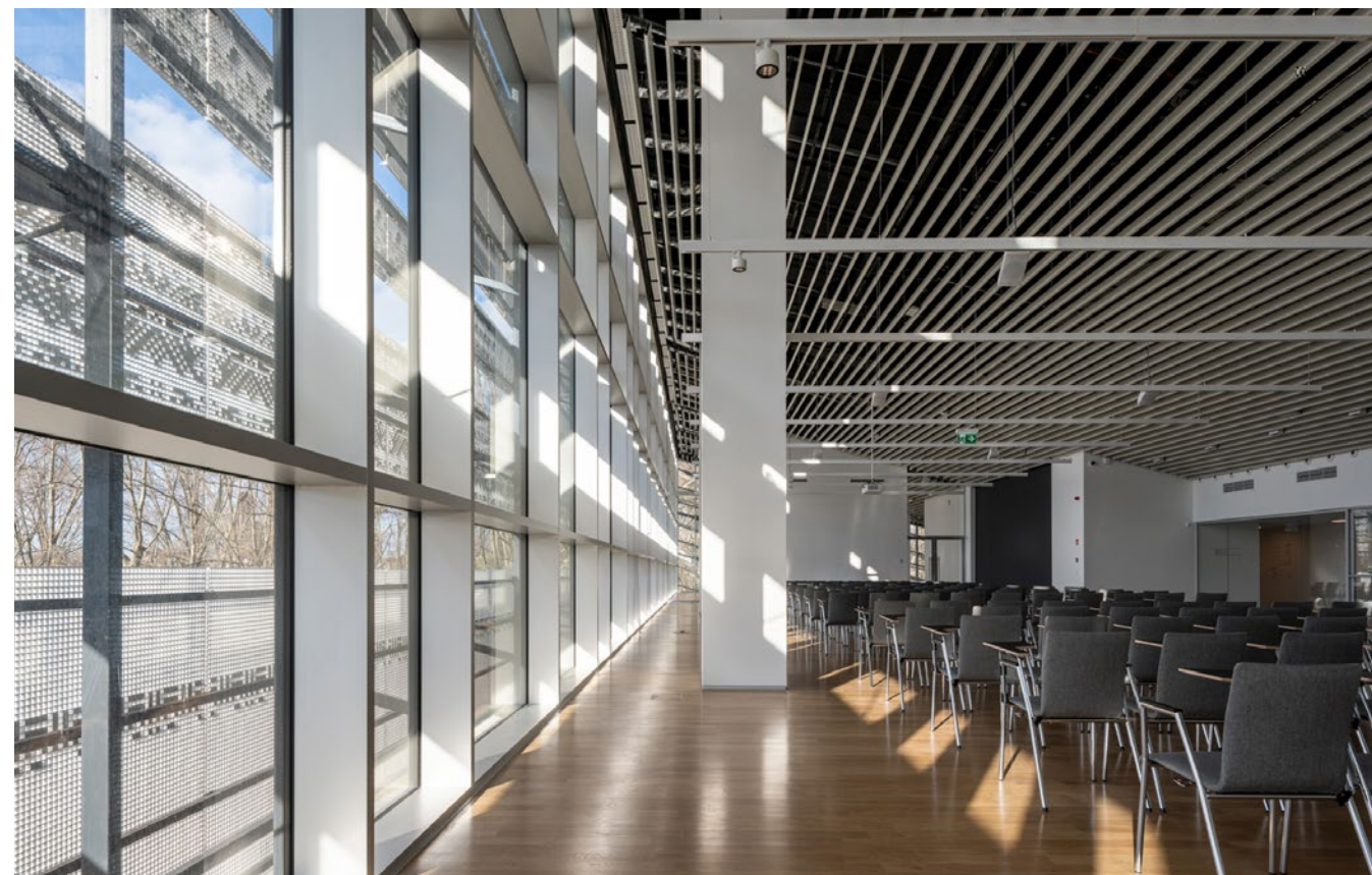
Design fasády zajišťuje zároveň zastínění budovy
