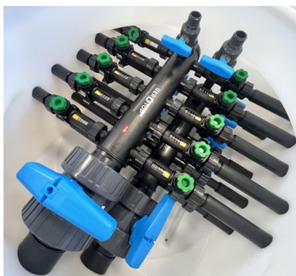
Svedení deseti vrtů v jímce a napojení na páteřní vedení do domu
