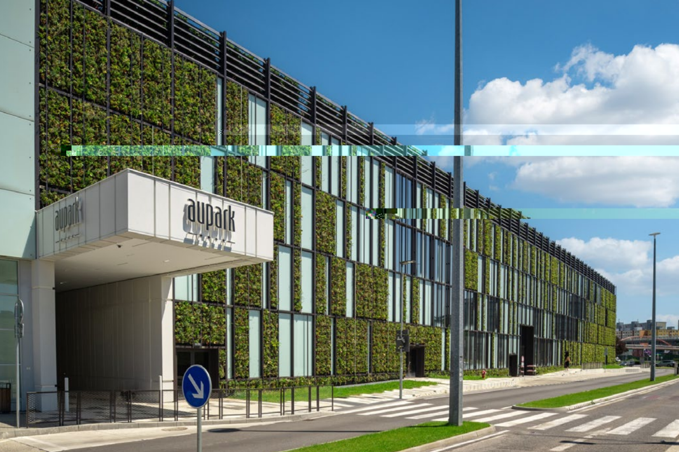
Hydroponický systém Biotile se skládá z kazet vyplněných speciální minerální vatou
